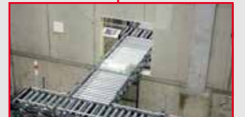
自動倉庫の背面からコンベヤで梱包工程と繋ぎ、入庫作業を効率化。
