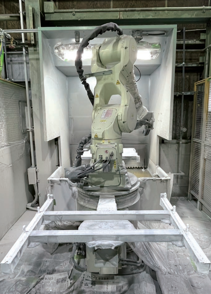
ロボット塗装ブース
