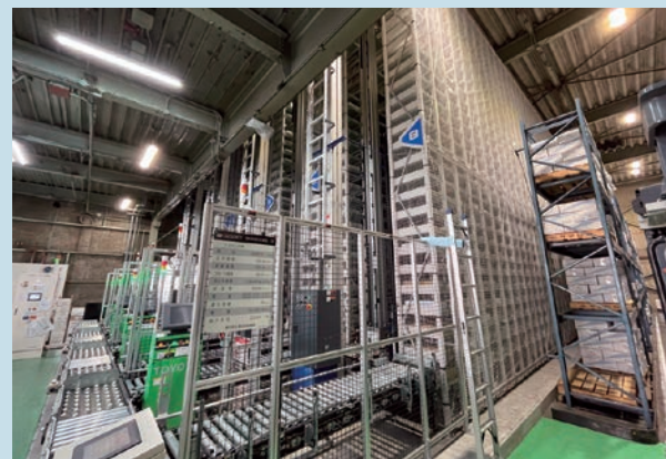
自動倉庫の導入でピッキングの効率が格段にアップ
